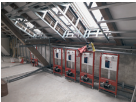
Průběh rekonstrukce MŠ.
