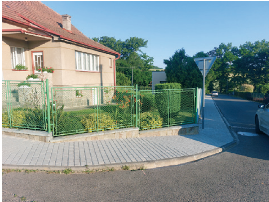
Dokončení chodníků a komunikace v lokalitě Horní Draha.
