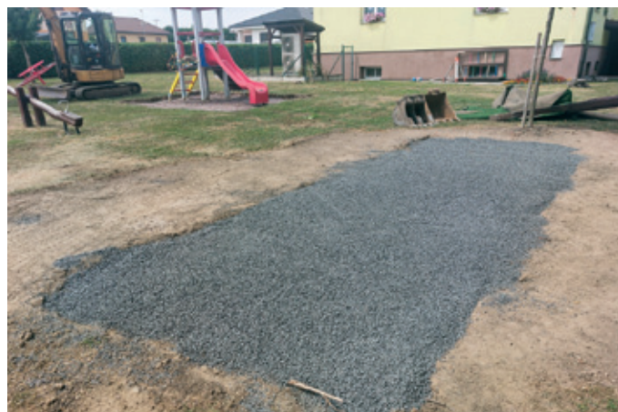
Přípravné práce před instalací herních prvků.
