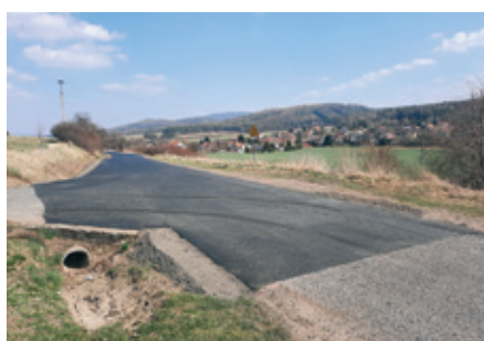
Oprava komunikace Hvozdec II.
