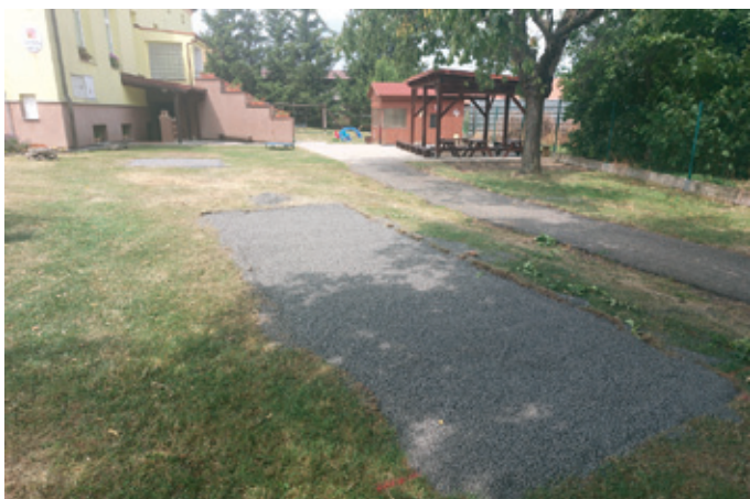
Před instalací herních prvků.
