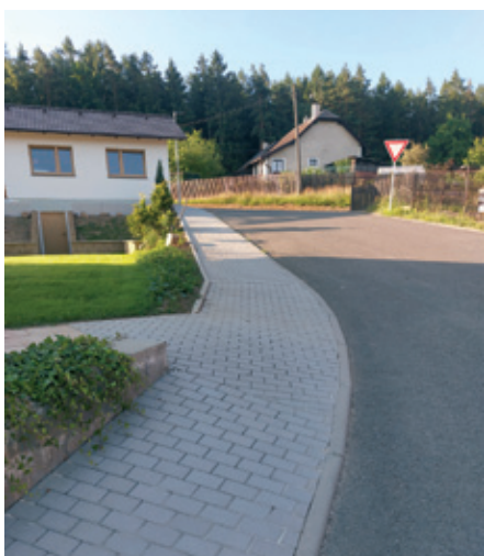
Dokončení chodníků a komunikace v lokalitě Horní Draha.
