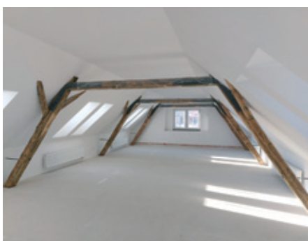
Průběh rekonstrukce budovy.
