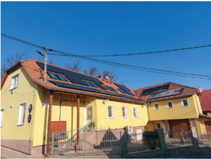
Instalace FVE na střeše budovy OÚ.
