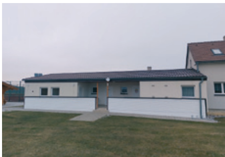
Opravená zeď kabin TJ.
