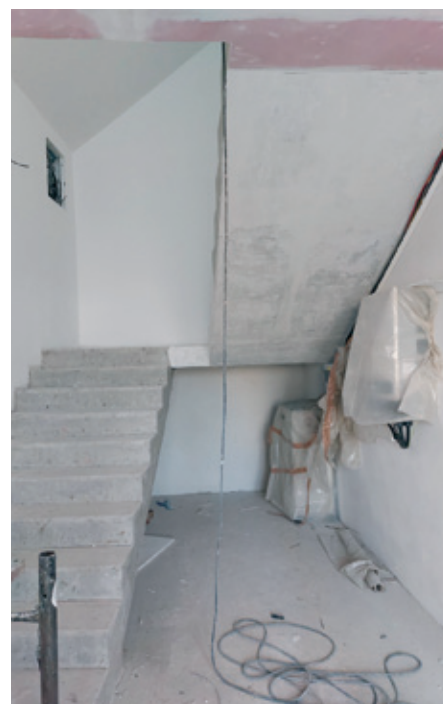
Průběh rekonstrukce budovy.
