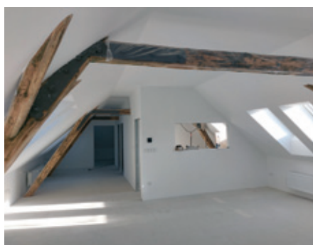
Průběh rekonstrukce budovy.
