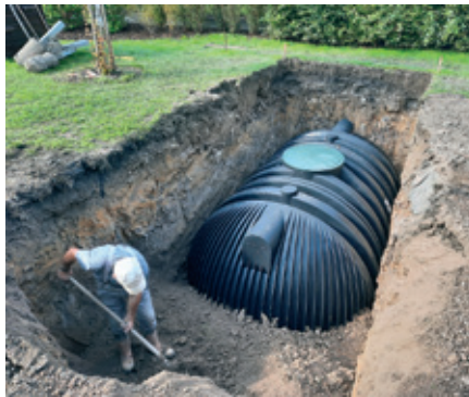
Uložení nádrže v areálu MŠ.
