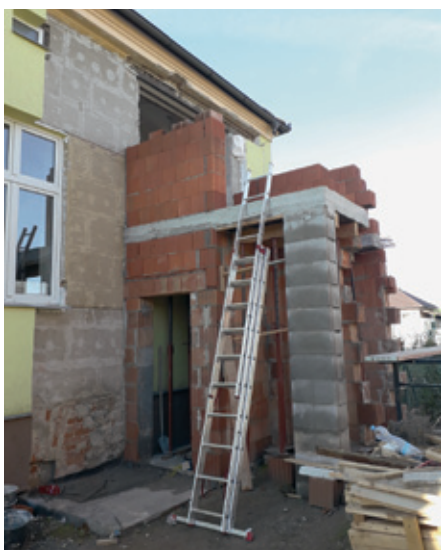
Začátek rekonstrukce MŠ.
