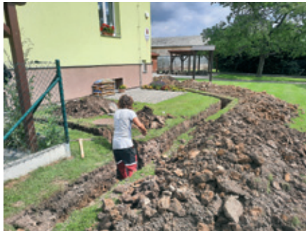
Práce na svedení dešťové vody do nádrže - MŠ.
