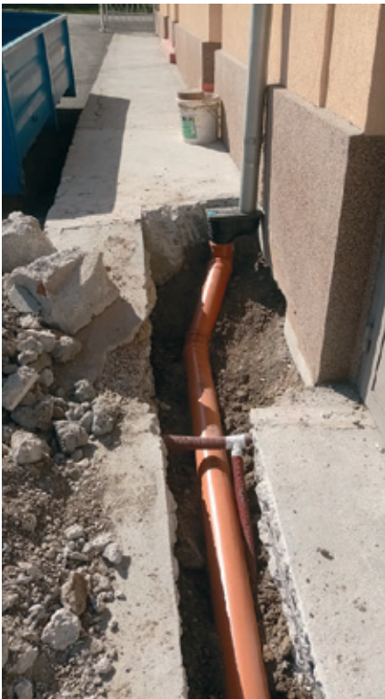
Práce na svedení dešťové vody do nádrže - Pastuška.
