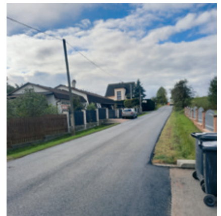
Oprava komunikace Hvozdec I.
