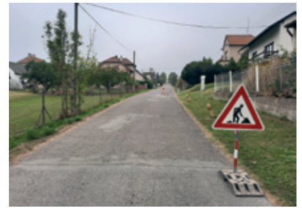
Oprava komunikace Hvozdec I.
