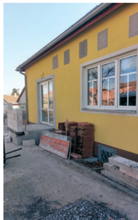
Průběh rekonstrukce budovy.
