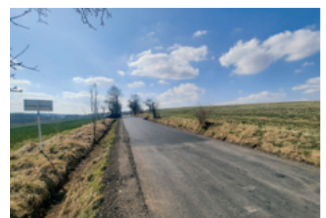
Oprava komunikace Hvozdec II.
