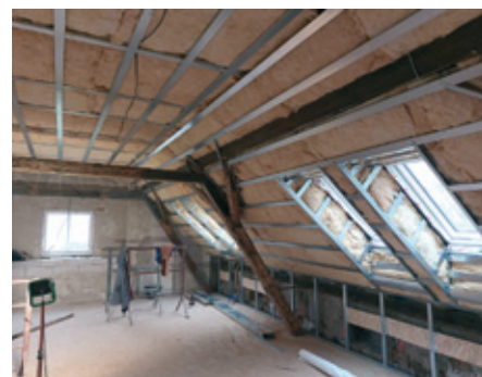
Průběh rekonstrukce budovy.
